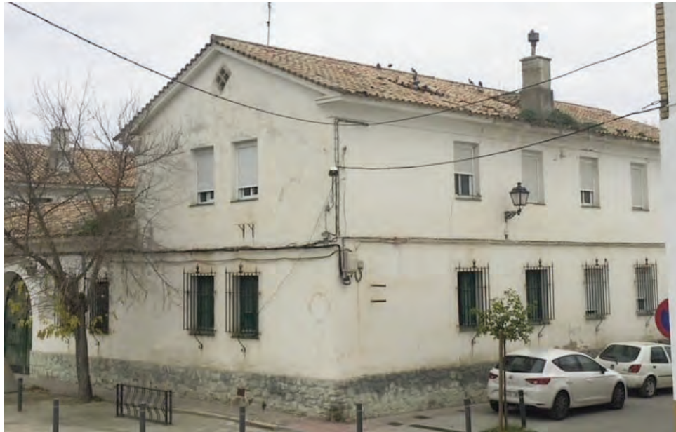
Antiguo cuartel de la Guardia Civil que va a sufrir la obra para la ampliación de la residencia.
